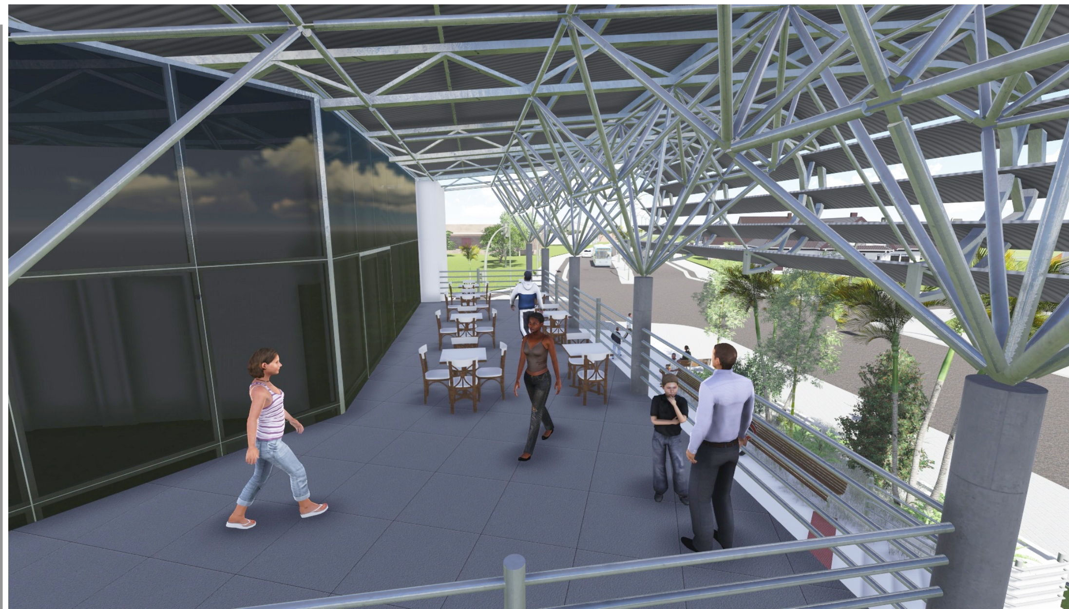
Vista externa do mezanino, demonstrando os pilares tipo árvore que sustentam a cobertura;
